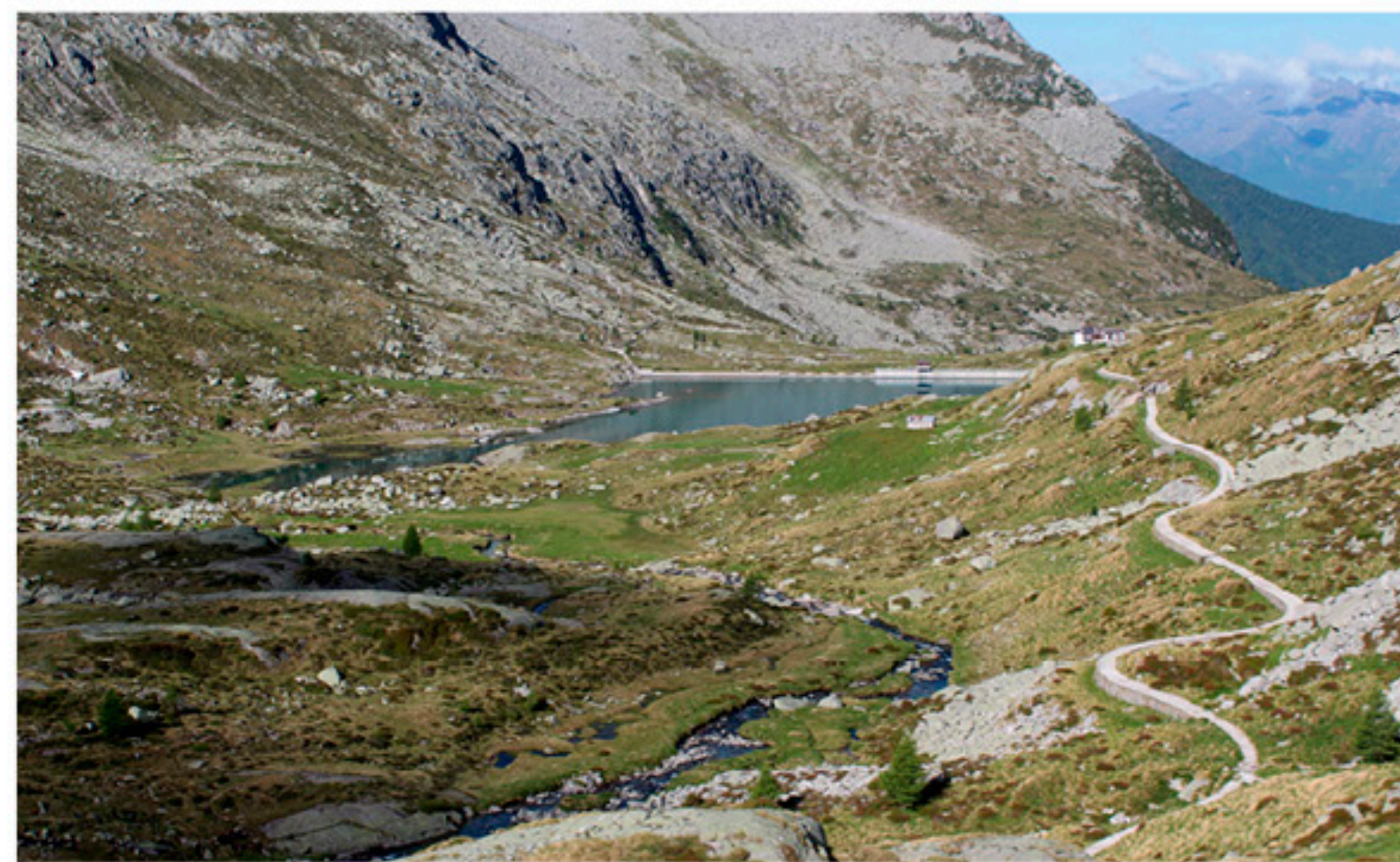
CANALE PRESA MILLER VERSO CENTRALE BAITONE (FOTO D. ROMELLI)
