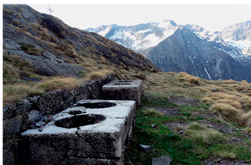
QUELLO CHE RIMANE DELLE CUCINE ESTERNE (FOTO D. ROMELLI)
